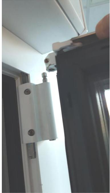
Dégondage : Ouvrir le châssis à la française, retirer complètement la vis, soulever le compas en maintenant l'ouvrant puis soulever l'ouvrant pour dégager le bas.
