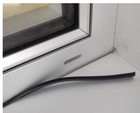
Réalisation un cordon continu d'étanchéité (agrée SNJF) en extrémité de
