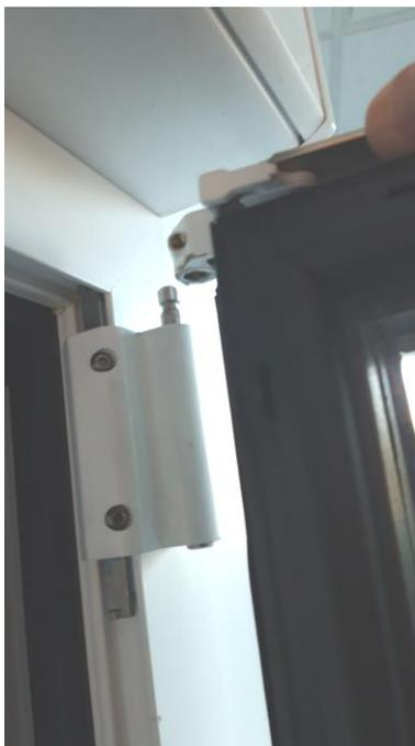
Dégondage : Ouvrir le châssis à la française, retirer complètement la vis, soulever le compas en maintenant l'ouvrant puis soulever l'ouvrant pour dégager le bas.
