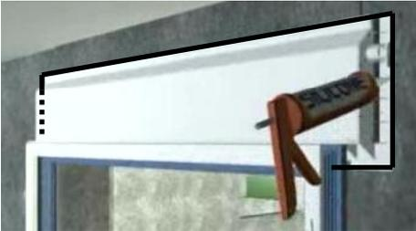
Compléter en réalisant, par l'intérieur, une étanchéité sur le tour du volet
