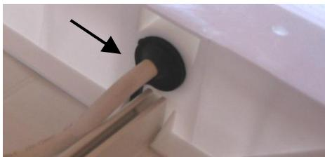
Volet électrique : avec un tournevis, percer l'opercule sur l'embout et passer le câble au travers
