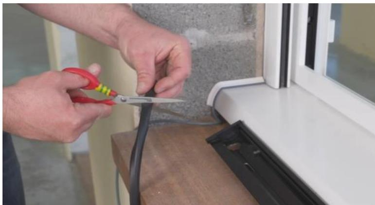
10. Faire passer le câble dans le perçage du profil recevant le panneau prévu a cet effet, et positionner le câble correctement sous la bavette au niveau de la rainure de clippage.
