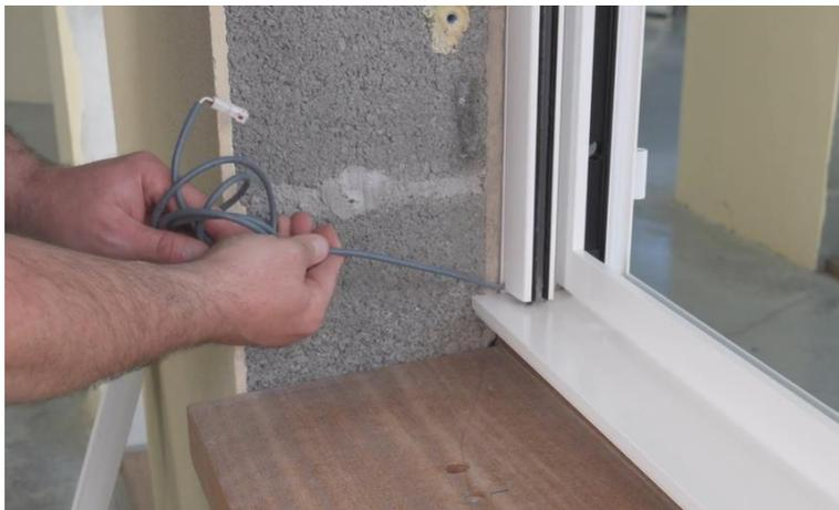
3. Tracer un repère et positionner le profil recevant le panneau au centre de la bavette.
