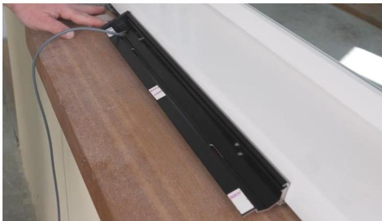
14. Raccorder le panneau solaire et le placer sur le profil aluminium, loger la sur longueur de câble entre le panneau et le profil (ne pas couper le câble !).
