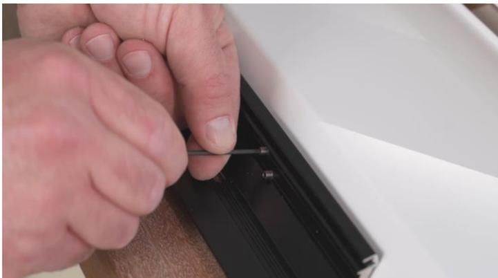
5. Positionner le 1<sup>er</sup> embout du profil recevant le panneau et le visser.
