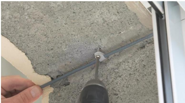
3. Présenter le profil recevant le panneau à l'emplacement souhaité, par rapport aux règles de positionnement du panneau, et repérer les fixations.
