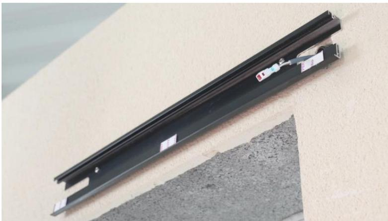
9. Raccorder le panneau solaire et le placer sur le profil aluminium, loger la sur longueur de câble entre le panneau et le profil (ne pas couper le câble !).
