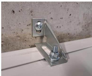
Fixer le coffre avec les pattes et les clameaux fournis sur le coffre ainsi que les vis penture et chevilles plastique.
