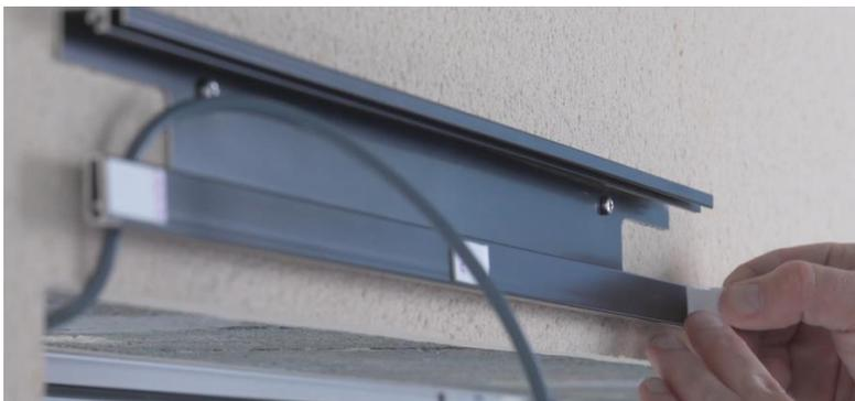
9. Raccorder le panneau solaire et le placer sur le profil aluminium, loger la sur longueur de câble entre le panneau et le profil (ne pas couper le câble !).
